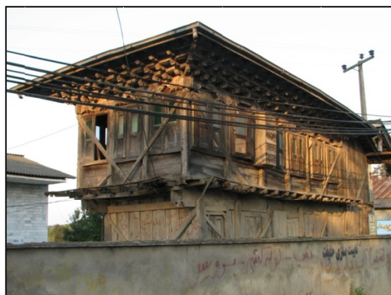
تصویر ۹. اتصالات در طبقه دوم (مأخذ: نگارنده).
