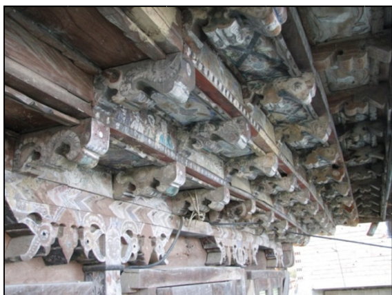
تصویر ۱۵. محل نشست شیرسرها و سایر عناصر سقف (مأخذ: نگارنده).
