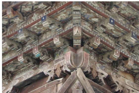
تصویر ۸. نحوه قرارگیری سرستون‌ها و تیرهای نال سقف در گوشه‌ها (مأخذ: نگارنده).
