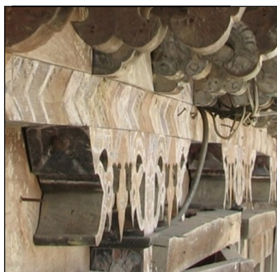
تصویر ۳۲. محل اتصال سرستونها به تیرهای نال سقف (مأخذ: نگارنده).
