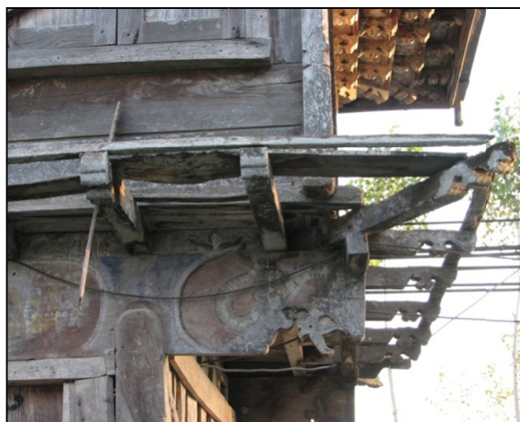
تصویر ۶. اتصالات نال به ستون‌ها و قرارگیری شیرسرها روی آن (مأخذ: نگارنده).
