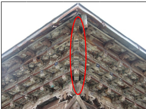
تصویر ۳۳. محل قرارگیری شیرسررها در قسمت کنج و زاویه دار سقف (مأخذ: نگارنده).
