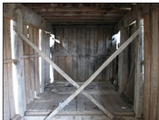
تصویر ۳۱. محل اتصال بادبندها به ساختمان (مأخذ: نگارنده).
