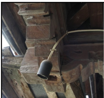
تصویر ۱۲. محل اتصال سرستون به ستون (مأخذ: نگارنده).
