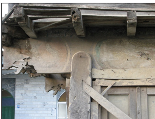
تصویر ۱۰. نحوه اتصال بادبند به ستون (مأخذ: نگارنده).
