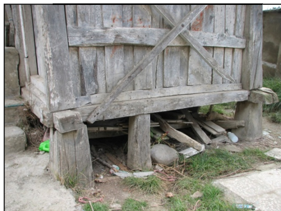
تصویر ۵. طبقه اول و اتصالات ستون به پایه‌ها (مأخذ: نگارنده).
